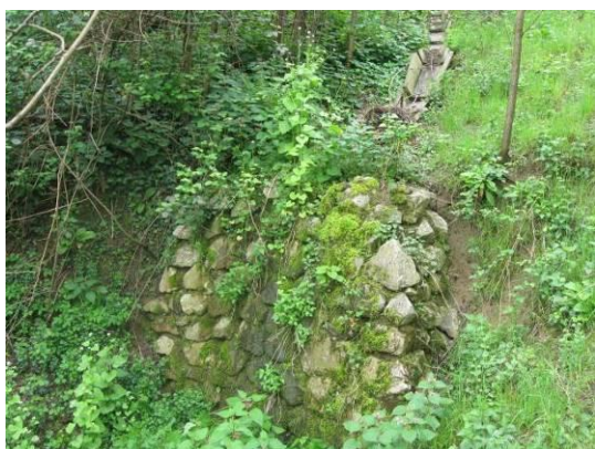
Slika 3,4: levo pomanjkljivo izveden stabilizacijski prag, poškodovane in zasute kanalete pred stabilizacijskim pragom (foto: R. Galič, april 2016)
