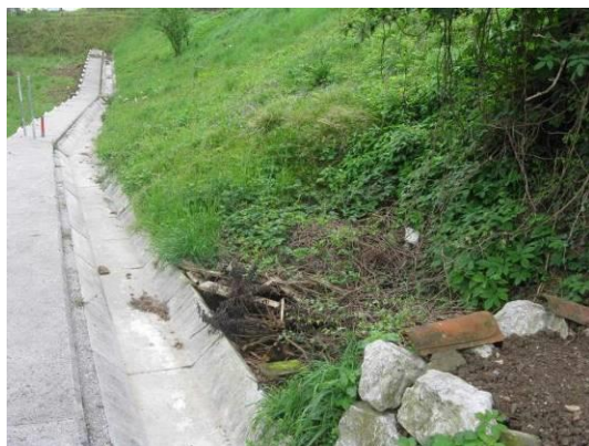
Foto 2: odprt izpust meteorne vode v zalednem delu kanala, voda pronica v podtalje in zamaka pobočje pod pilotno steno (Foto: R. Galič, april 2016)
