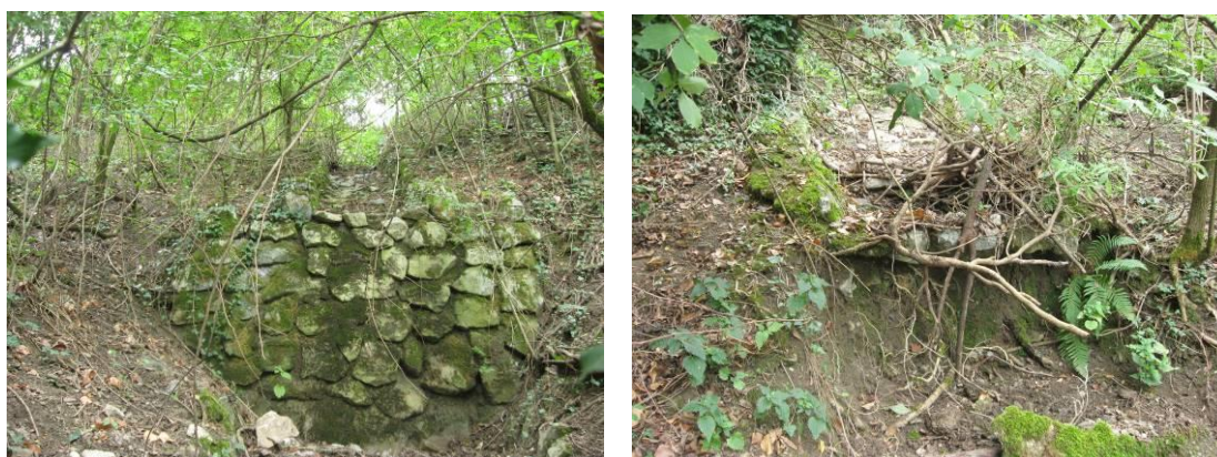
Slika 7,8: levo pogled na stabilizacijski prag v osrednjem delu kinete, desno močno spodkopan in nezavarovan zaključek kinete (foto: R. Galič, avgust 2022)
