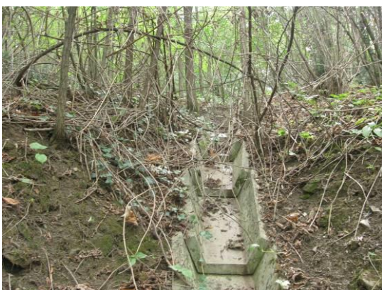
Slika 5,6: pogled na kanalete v spodnjem delu, desno vtok v betonski jašek fi 60 cm v vkopni brežini ceste (foto: R. Galič, avgust 2022)
